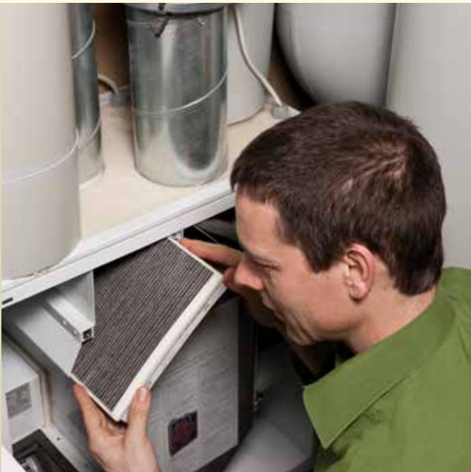
تعویض فیلتر سیستم تهویه
