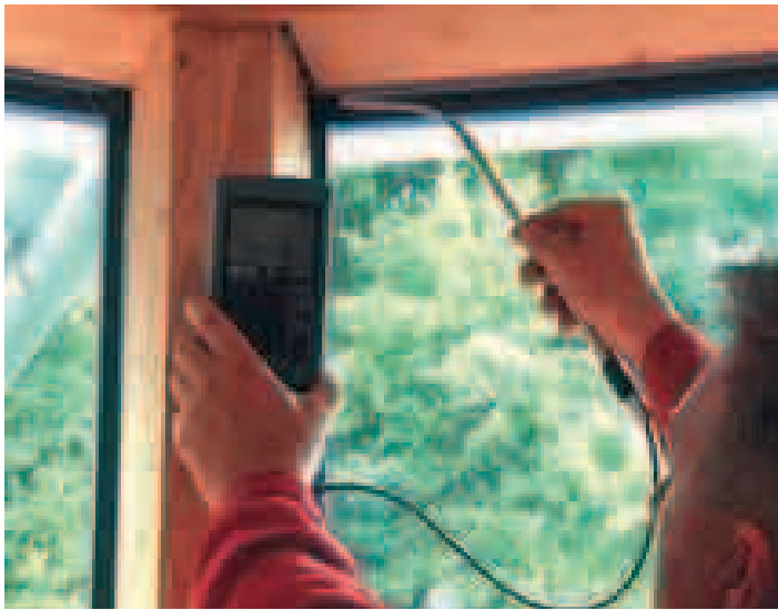
Fotografía 5. Control de infiltraciones en las ventanas. Fuente: Google.
