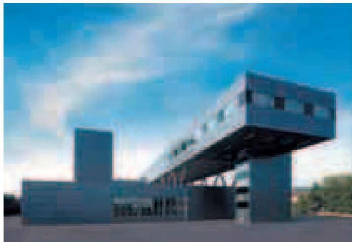
Fotografía 11. Estación de Bomberos en Heidelberg (Alemania). Fuente: iPHA.
