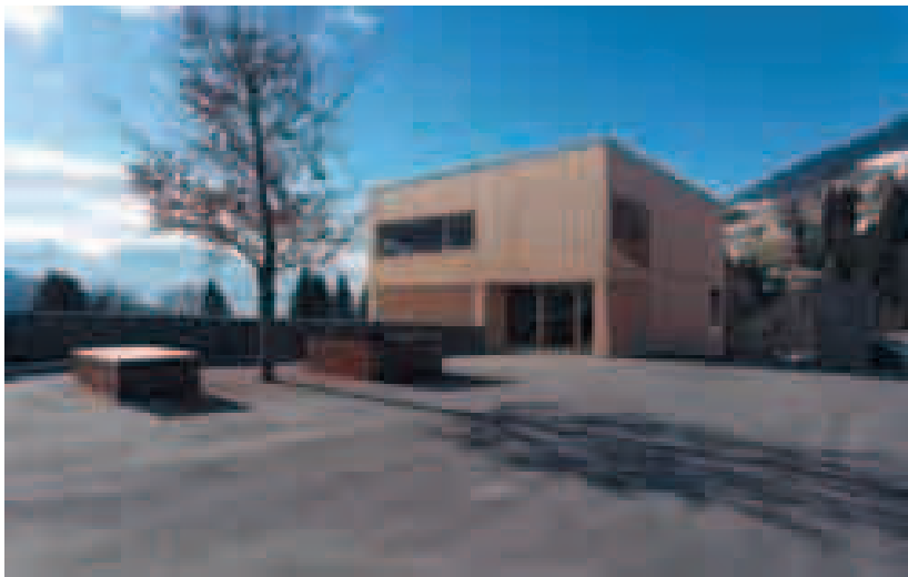
Fotografía 8. Oficinas en St. Gerold (Austria). Fuente: iPHA (International PH association).
