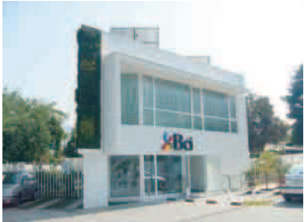
Fotografía 6. Vista entrada banco de Crédito e Inversiones BCI, Chile. Fuente: M. Huenchuñir.
