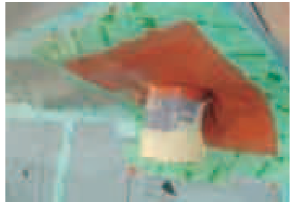
Fotografías 15 y 16. (Izq.) Paso de un tubo de ventilación en la cubierta. (Drcha.) Solución con collarines y cintas adhesivas. Fuente www.blowerdoor.de .
