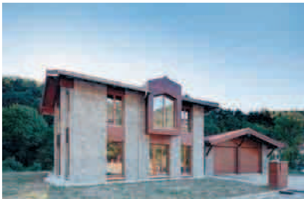
Fotografía 16. Casa Arias, Roncal en Navarra. Fuente: Ariel Ramírez.
