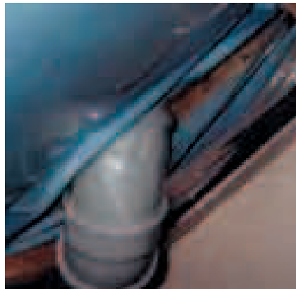
Fotografías 15 y 16. (Izq.) Paso de un tubo de ventilación en la cubierta. (Drcha.) Solución con collarines y cintas adhesivas. Fuente www.blowerdoor.de .
