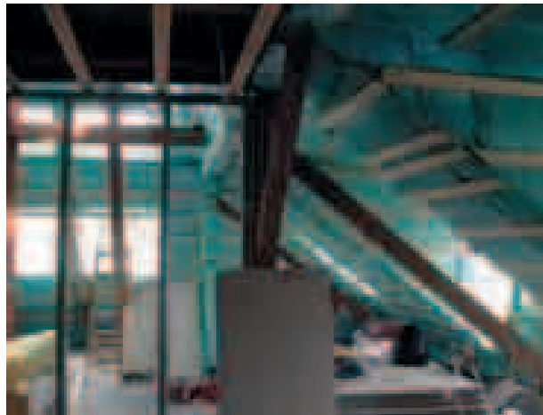
Fotografías 5 y 6. (izq.) El aislamiento es aún visible (planchas y paneles de madera): Este es el momento óptimo para una medición BlowerDoor. (dcha.) Estructura BlowerDoor instalada y lista para la búsqueda de infiltraciones.
