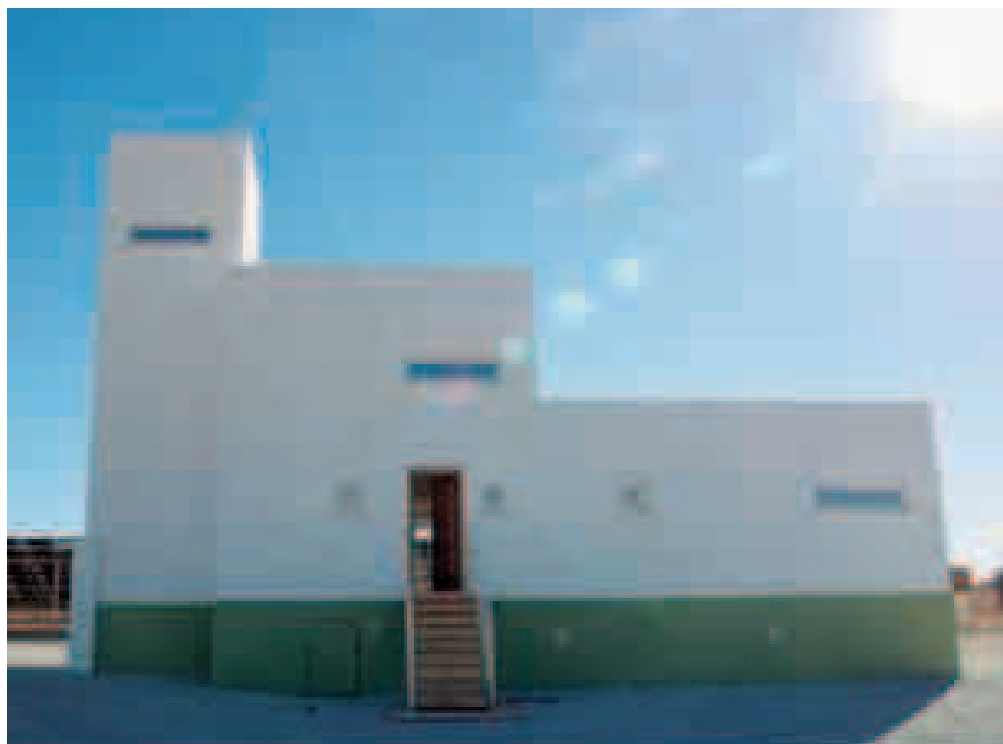
Fotografía 13. Casa unifamiliar en Moraleda de Zafayona, fachada acceso. Fuente: Ecoholística.
