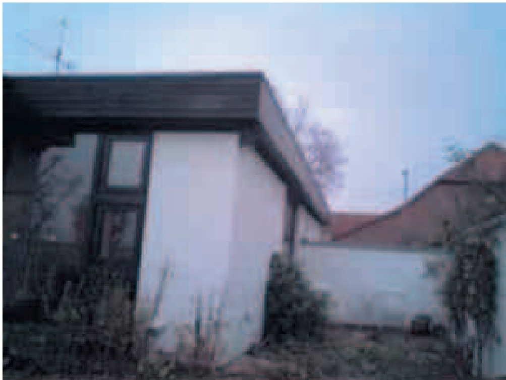
Fotografía 9. Exterior de edificio; vista suroeste.
