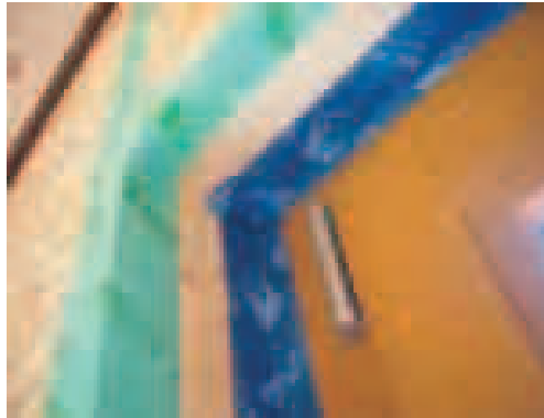
Fotografías 17 y 18. (Izq.) Sellado de estructura de madera. (Dcha.) Sellado de unión de la ventana con la estructura de madera. Fuente: Wolfgang Berger, www.arkimo.es .
