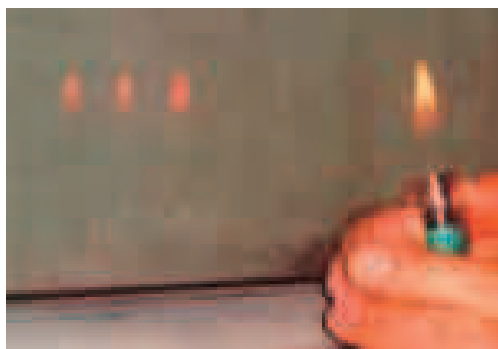
Fotografía 3. Imagen de comprobaciones en obra de la posición de las láminas en los vidrios Fuente «Passivhäuser im Sonnenfeld» Autores Joachim Zeller y Claus Kahlert.
