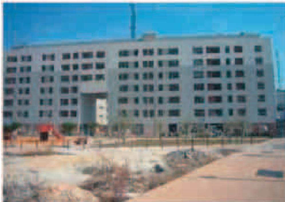
Fotografía 1. Edificio en fase de construcción.
