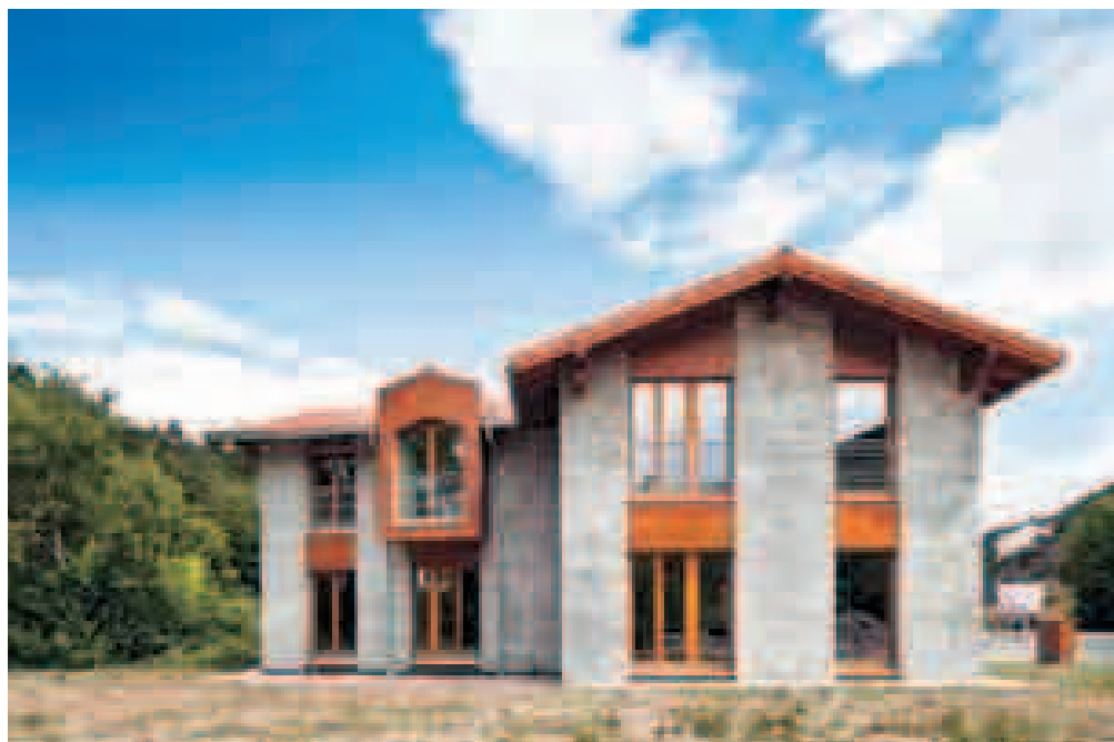
Fotografía 15. Casa Arias, Roncal en Navarra. Fuente: Ariel Ramírez.
